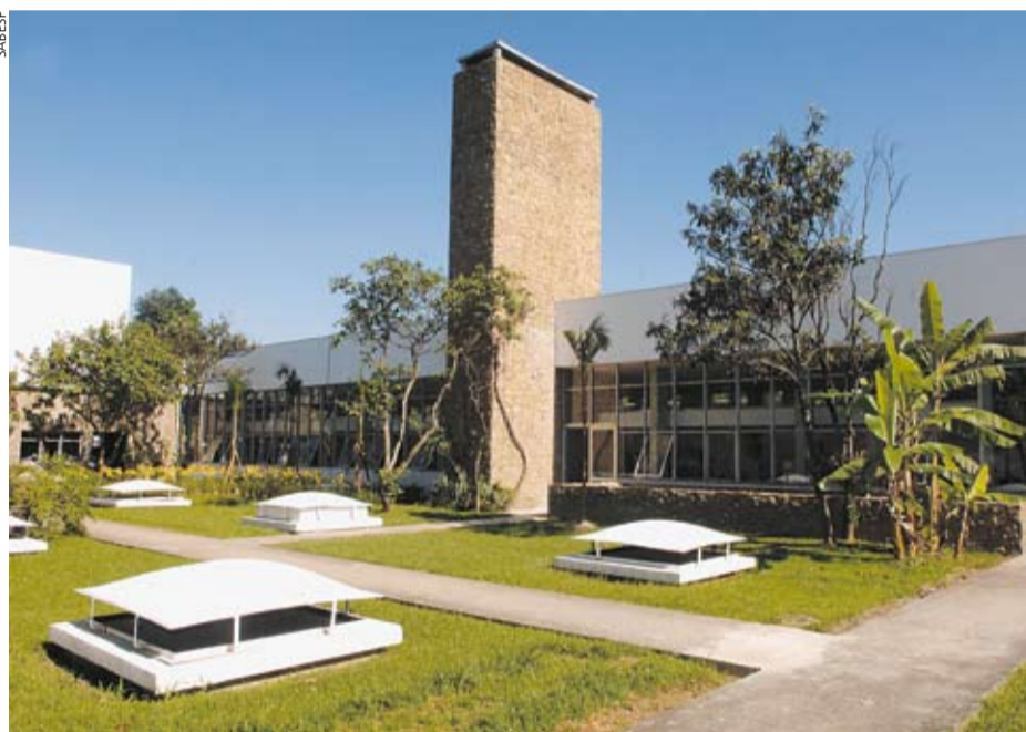
Antiga estação elevatória da Sabesp será a sede da Superintendência de Gestão Ambiental
